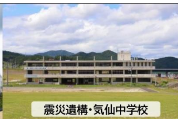
震災遺構・旧道の駅タピック45
