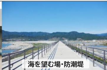
東日本大震災津波伝承館・前
