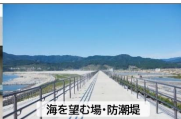
東日本大震災津波伝承館・前
