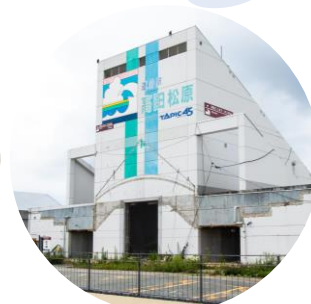
旧道の駅高田松原 タピック45
