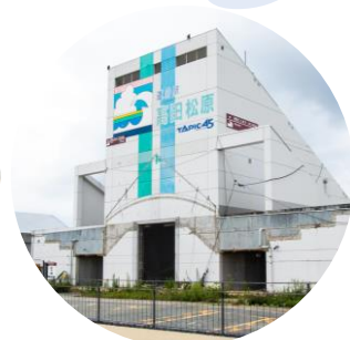
旧道の駅高田松原 タピック45
